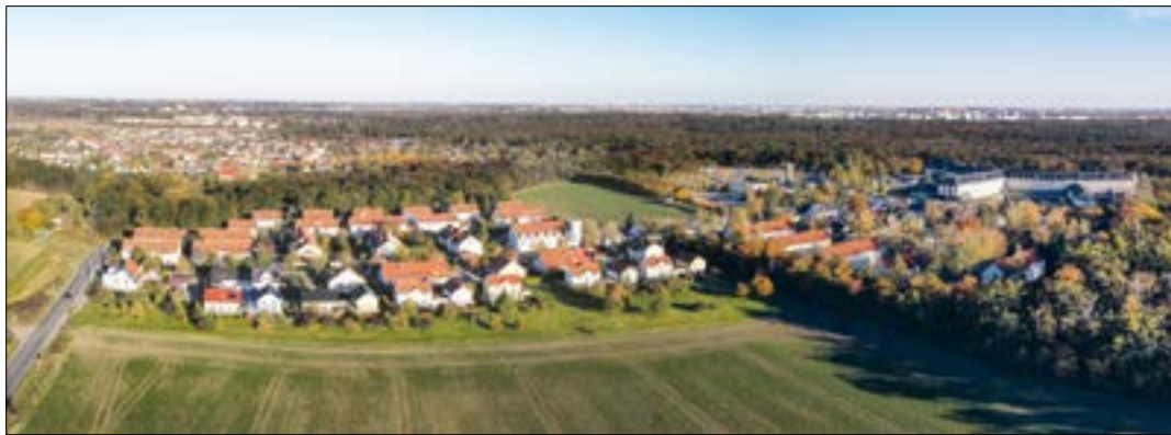
Luftbild der Krankenhausiedlung vom August 2025, Foto: Silvio Kelz
